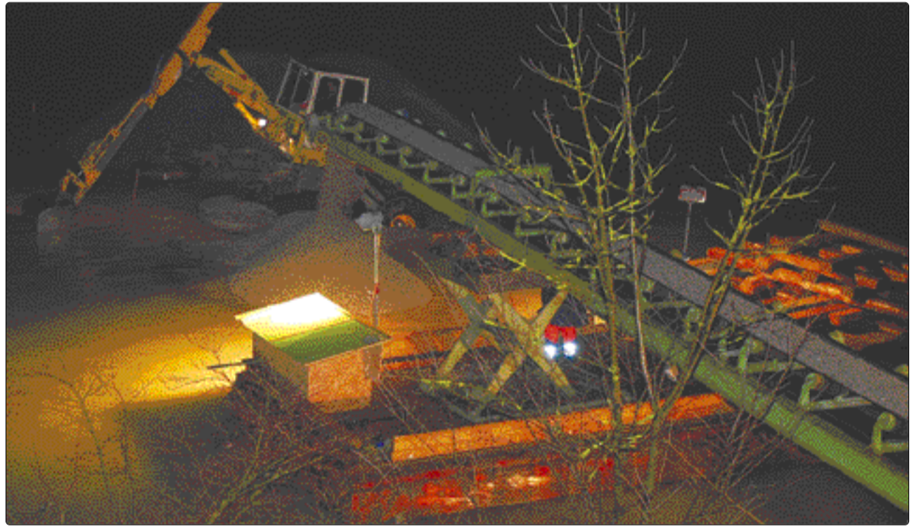
Über ein Förderband wird Kies von einem Güterwaggon direkt in den See befördert. Reto Schneider
